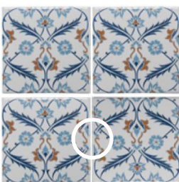
Dit is niet goed; de patronen aan de zijkant sluiten niet op elkaar aan, omdat de tegel rechts onderin op zijn kop staat
